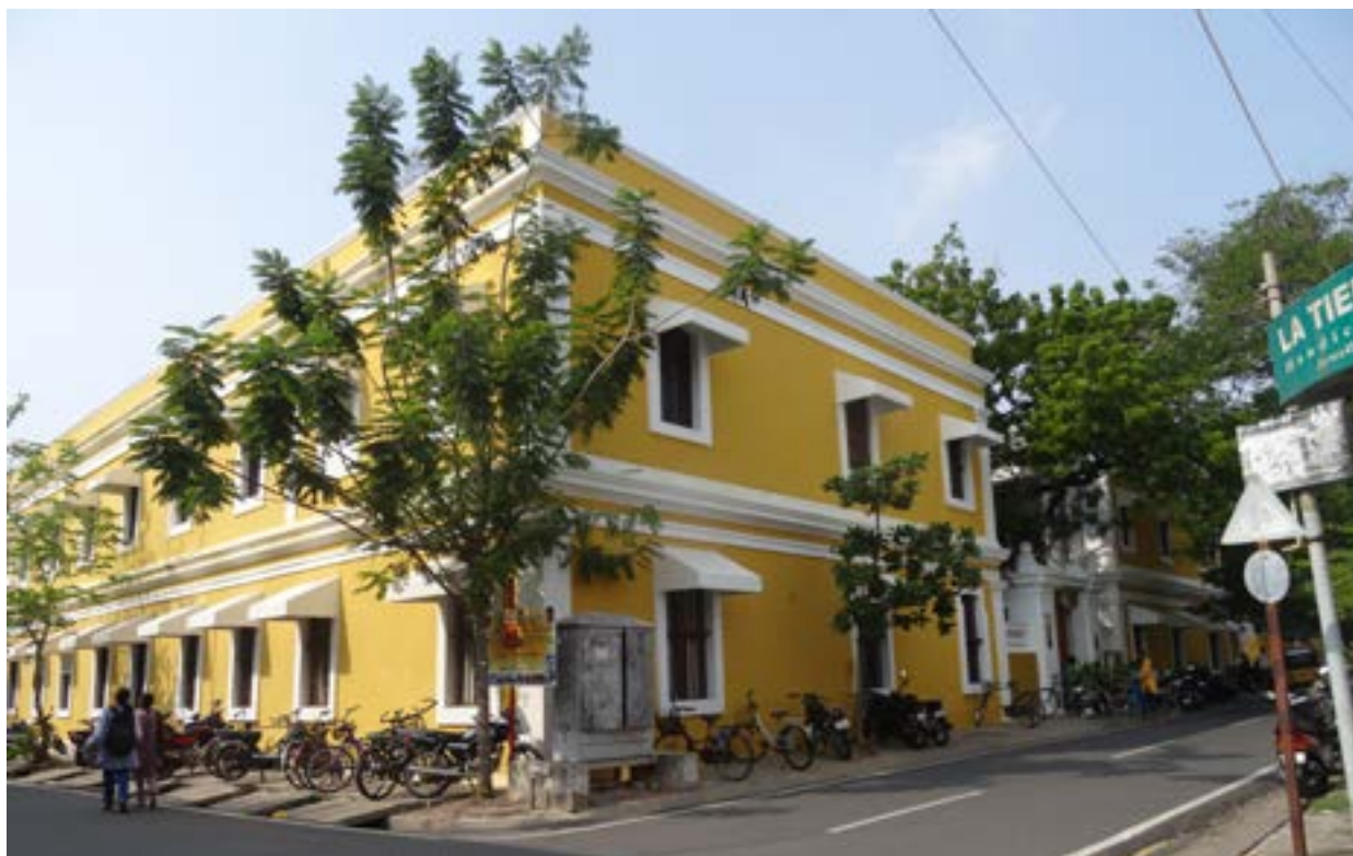
Le Lycée français de Pondichéry (bâtiment du milieu du XIX e siècle) accueille près d'un millier d'élèves.
