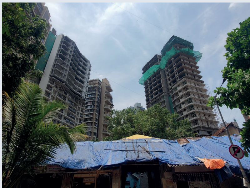
Un paysage urbain incarné par les travaux, Mumbai.
