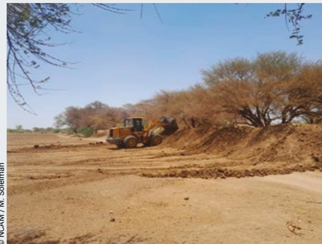
Figure 4 : Renforcement de la digue protégeant le site de Méroé
