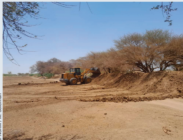
Figure 4 : Renforcement de la digue protégeant le site de Méroé
