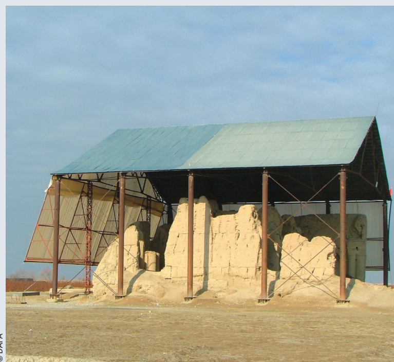
Figure 2 : La mosquée sous son abri après la pose du géotextile
